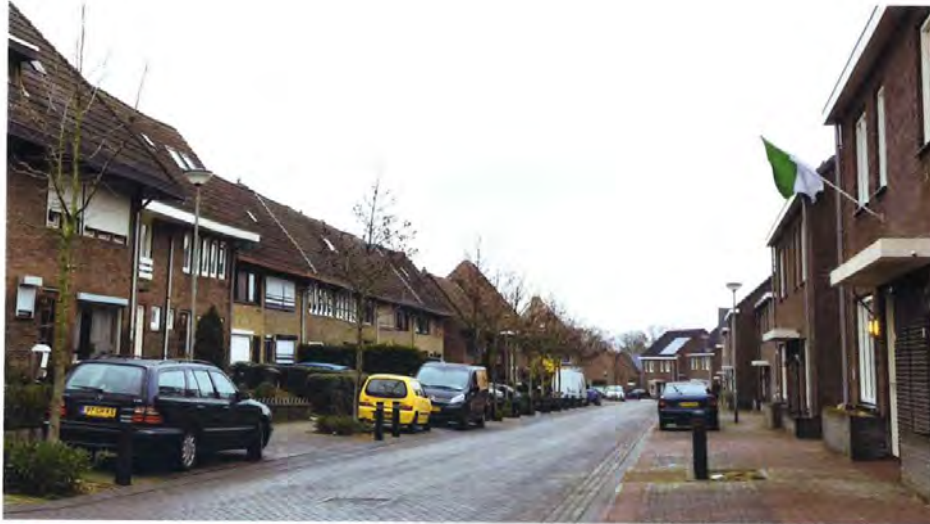
De Gulikstraat, zo te zien een doorgewone straat in een woonwijk. Links in het midden het blok van acht woningen dat opgekocht en gesloopt moet worden. Rechts nieuwbouw met goede fundering.
