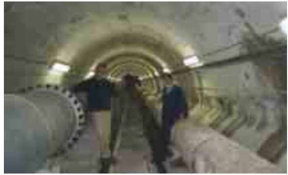
Figuur 2. Inspectie van de leidingen van Ceres Dam door 2 Ingeokring leden
