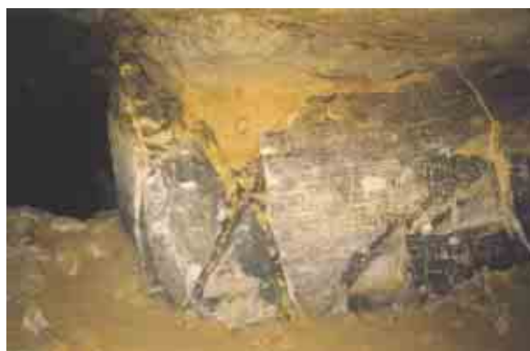
Fig. 5. Enkele decimeters ineen gedrukte pilaar.
