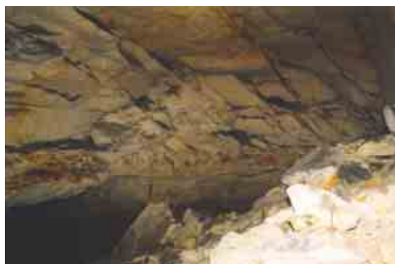
Fig. 7. Koepelvorming tot 6 m boven het oorspronkelijke dakniveau.
